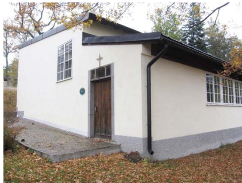
Kyrkan sydost om huvudbyggnaden. (Byggnad nummer 6)
