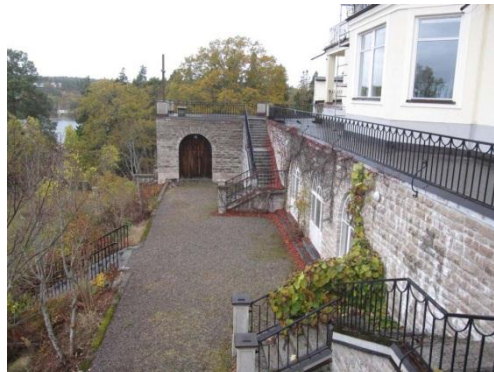
Del av terrasanläggningen. (Byggnad nummer 5)
