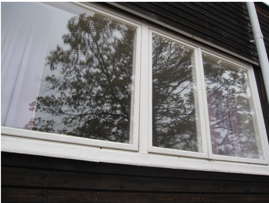
Gästhemmet, detalj fönster.
