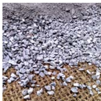
Där grusyta har lägre krav på bärighet kan kokosnät användas för att hindra grus från att blandas med växtjord. (Foto: Örjan Stål)
