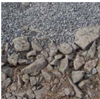
Luftig grusyta med låsande lager av makadam. (Foto: Örjan Stål)
