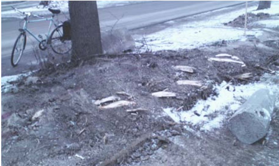
En vanlig situation för träd där ledningsstråk och hårdgjorda ytor anläggs i trädets absoluta närhet. Trädet har tillfogats obotliga skador i rotsystemet. Upprepade schakter, felaktig beskärning och dåliga växtförutsättningar skapar framtida s.k. riskträd i staden. (Foto: Uppsala kommun)
