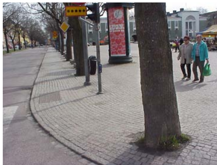
Vid dåliga markförhållanden växer gatuträd där det finns luft och fukt d.v.s i sätsanden direkt under ytskiktet. De med tiden allt grövre rötterna pressar beläggningsytan uppåt och spräcker ytskiktet. (Foto: Örjan Stål)
