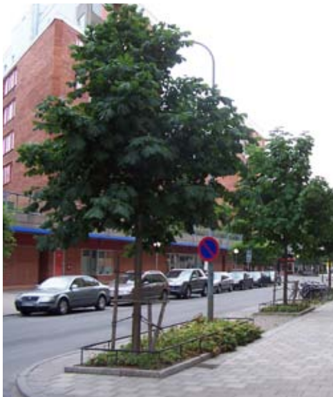
Nyanlagd gångbana med gatutråd i Stockholm. Träden har en underplantering av flocknavor. 15 m 3 skelettjord/träd och luftigt bärlager är lagd under den hårdgjorda beläggningen. Dagvatten från hustaken leds via skålförmade betongrännor till luftnings- och dagvattenbrunnar. (Foto: Björn Embrén)
