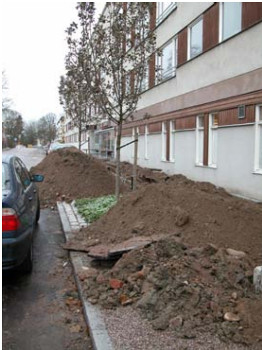
Efter: Felaktig behandling vid schaktarbeten. Det luftiga slitlagret är igensatt av lera. (Foto: Rita Engberg)
