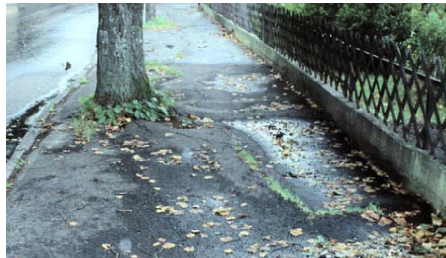
Vid dåliga markförhållanden växer gatuträd där det finns luft och fukt d.v.s i sätsanden direkt under ytskiktet. De med tiden allt grövre rötterna pressar beläggningsytan uppåt och spräcker ytskiktet. (Foto: Örjan Stål)
