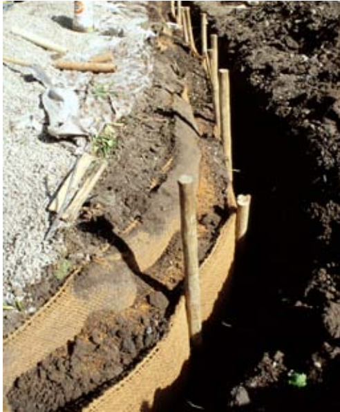
Rotdraperi med kokosduk. (Foto: Örjan Stål)
