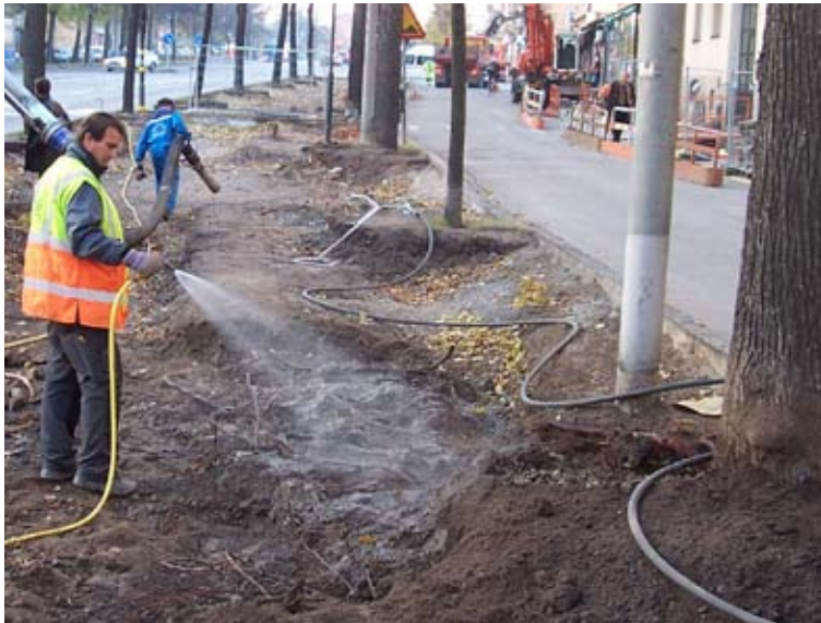
Frilagda rötter vid vakuumschaktarbeten bevattnas som skydd mot torka. (Foto: Björn Embrén)
