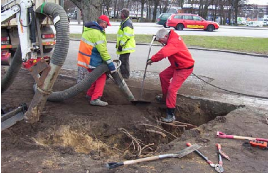
I områden med mycket trädrötter används rotvänlig schakt. Här med vakuumsug samt tryckluftlans. Metallansen används både till schakt och till luckring. (Foto: Örjan Stål)
