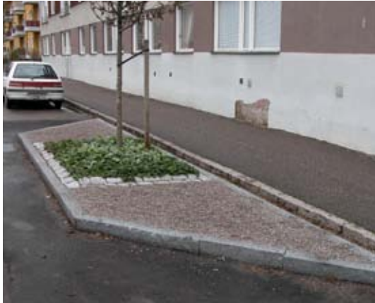
Före: Skelettjord med armerad luftig grusyta. (Foto: Rita Engberg)
