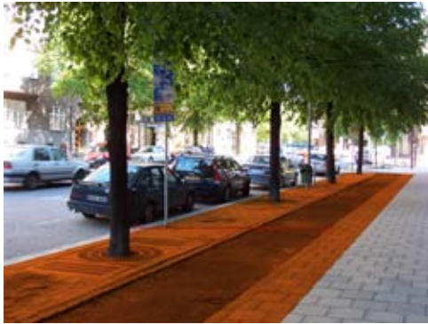
Återställning av nytt ytskikt med betongplattor. Ram för trädgaller läggs på betongglåda eller betongsyallar. Den färdiga anläggningen har en rottningsbar växtvolym på 15 m 3 per träd. Orange fält illustrerar ungefärlig bredd på det sammanhängande skelettjordsstråket. (Foton: Björn Embrén)
