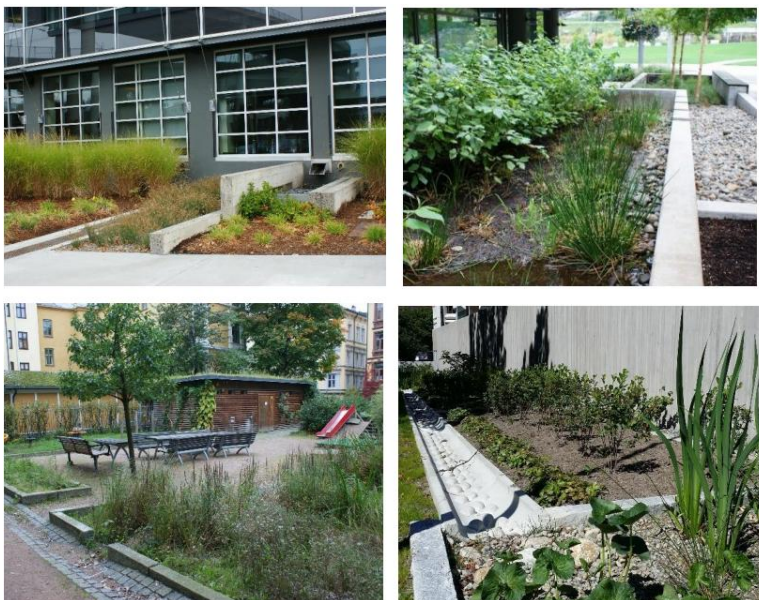
Figur 8. Exempel på nedsänkta och upphöjda regnbäddar med vegetation.
