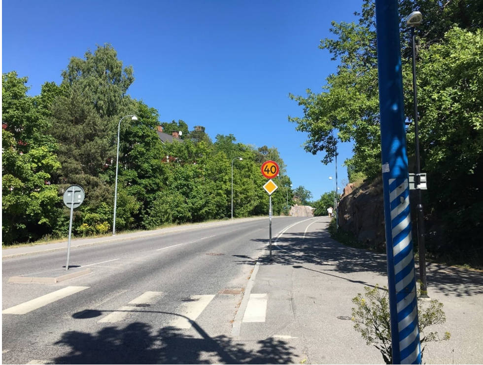
Figur 1. Kvarnholmsvägen mot öster, från rondell vid Finnbergstunneln. Hantverkshuset/Sicklaön 37:45 beläget på höger sida.
