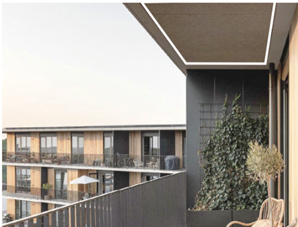
Figur 16. Absorbenter på undersida balkong (Balneum, Genova).
