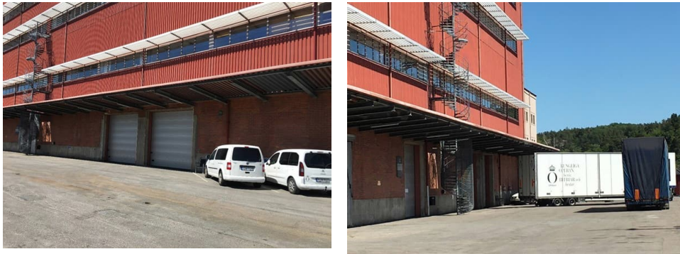
Figur 11. Garageportar på fastigheten Sicklaön 37:49.
