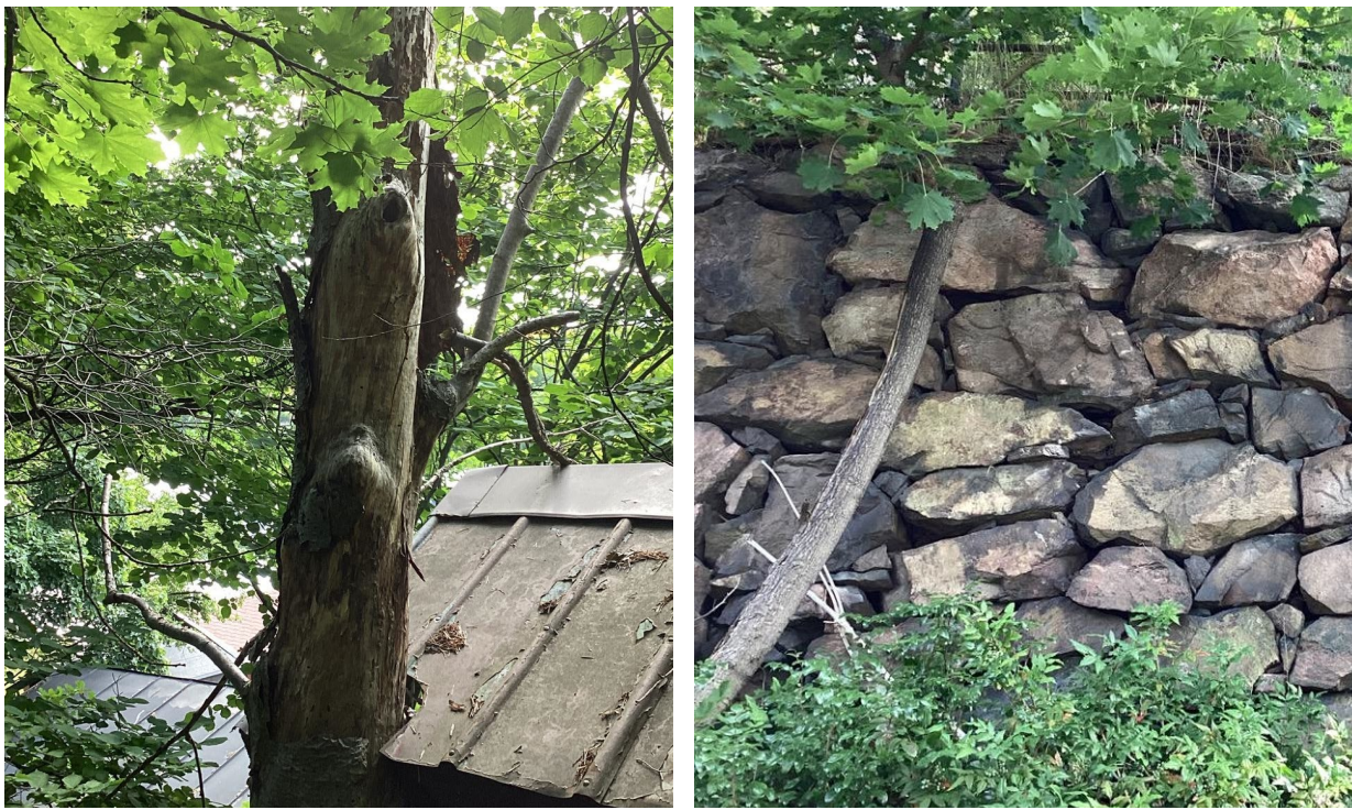
Figur 4. Exempel på strukturer lämpliga för fladdermöss i form av träd med håligheter och uppsprucken bark samt en stenmur med skrymslen.
