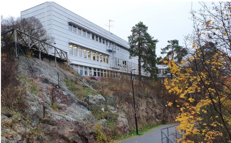
Figur 2: Vy mot nordost. Foto från platsbesök (2022-10-31).
