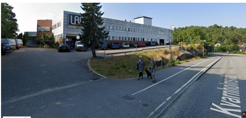
Figur 3: Vy mot sydväst. (Källa: Google Maps 2023)
