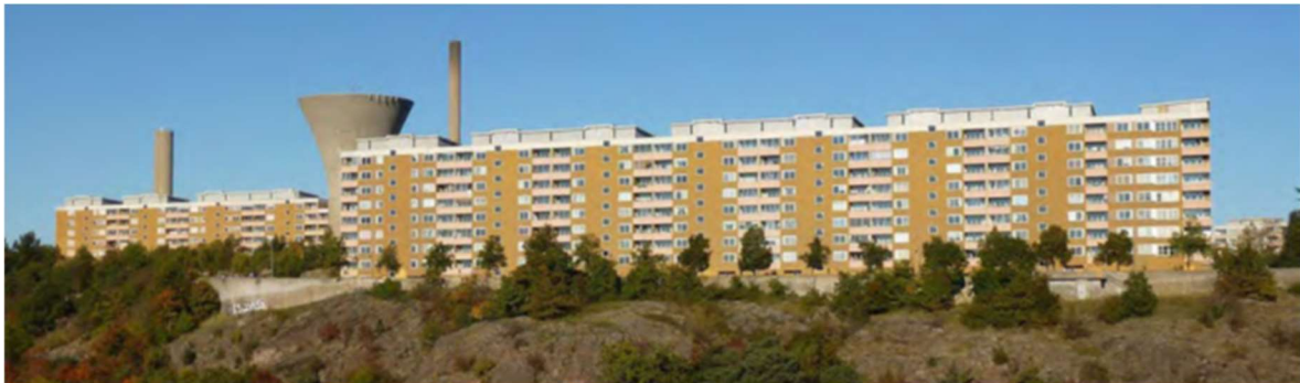
Figur 3. Vy från Alphyddan mot Henriksdalsberget. Den borgliknande bebyggelsen som tillsammans med skorstenar och vattentorn bildar ett påtagligt landmärke i stadsbilden. (Foto: Nacka kommun)
