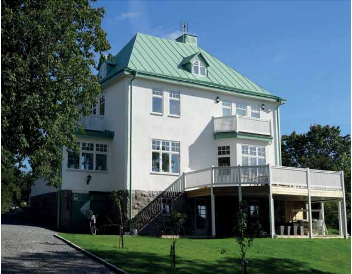
Igelboda 10:2 sedd från Sättravägen.
