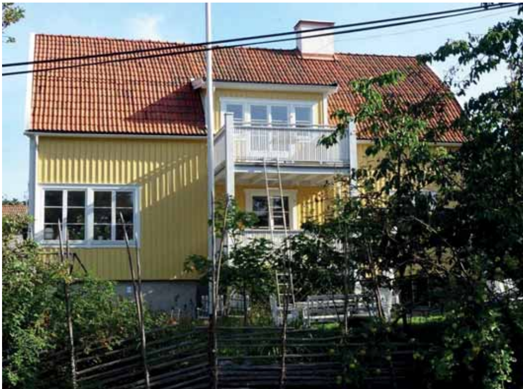
Fasaden mot Vasavägen präglas av en tillbyggnad och andra ändringar.
