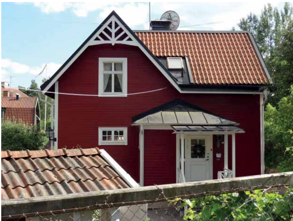
Igelboda 12:8 sett från norr.
