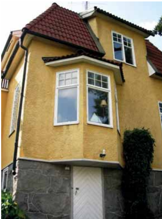
Detalj av fasaden med burspråket.
