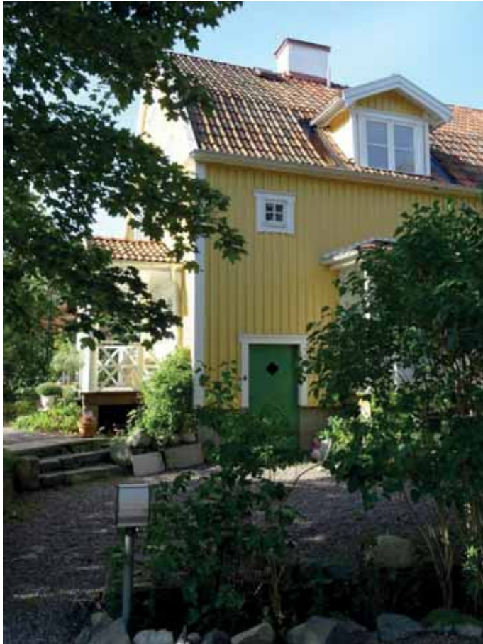
Igelboda 19:1, byggnadens ursprungliga del sedd från Irisvägen.
