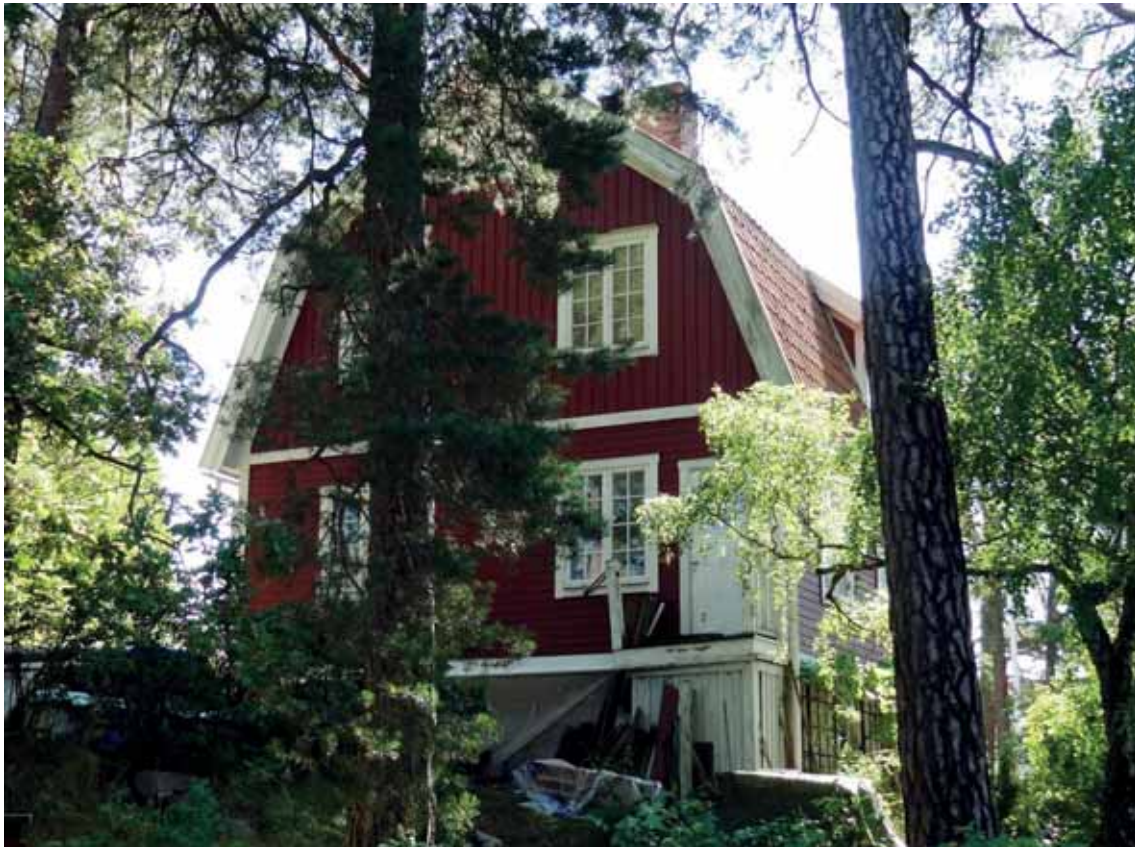
Igelboda 22:7 nordvästra gaveln sedd från Branta stigen.
