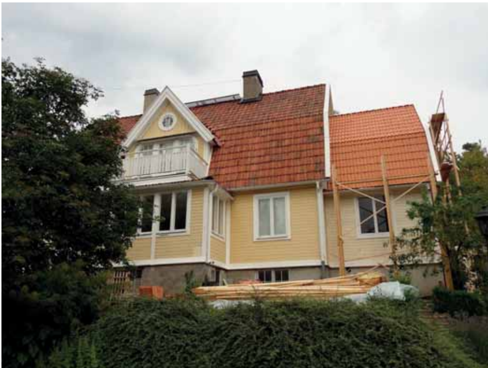
Byggnadens framsida med utbyggd veranda samt tillbyggnad i öster.
