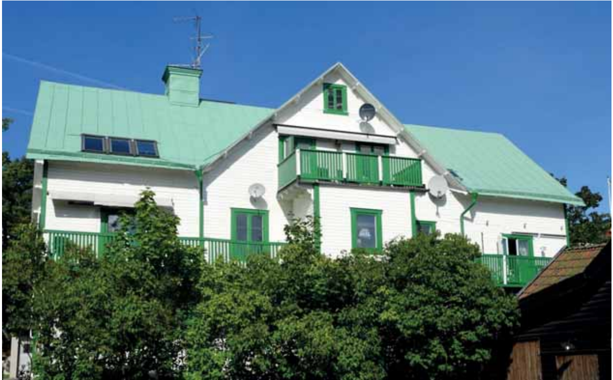
Igelboda 45:5 sett från söder.
