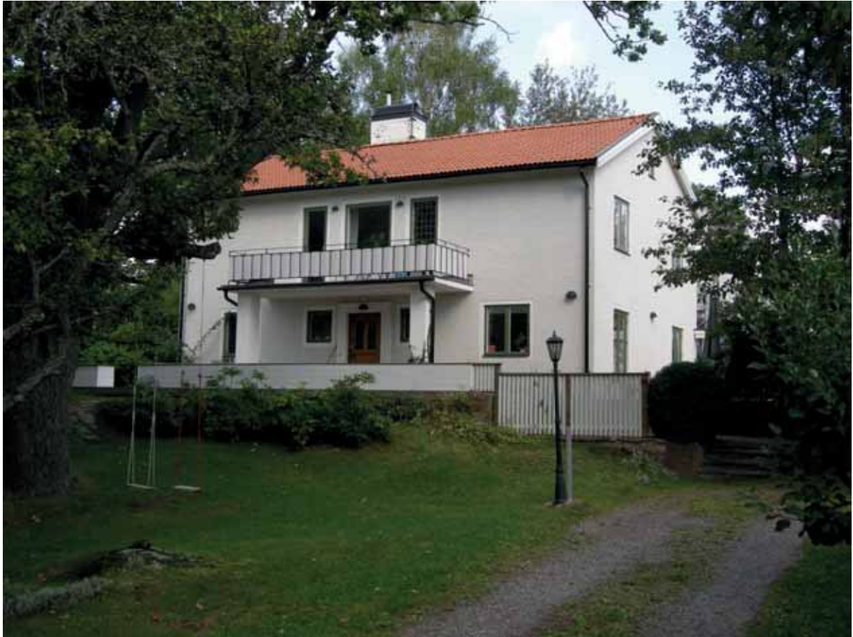
Igelboda 35:3 sett från Valhallavägen.
