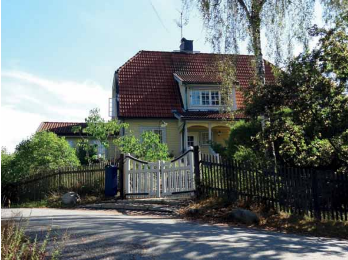
Igelboda 23:19, huvudfasaden sedd från Norevägen.
