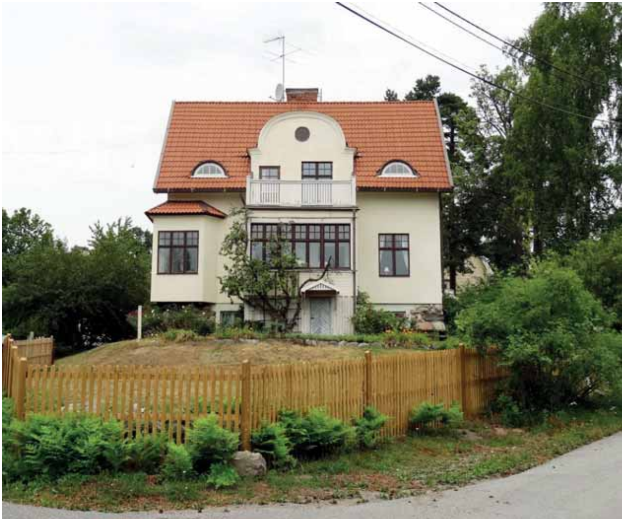
Igelboda 20:6 sett från hörnet Sagavägen/Odenvägen.
