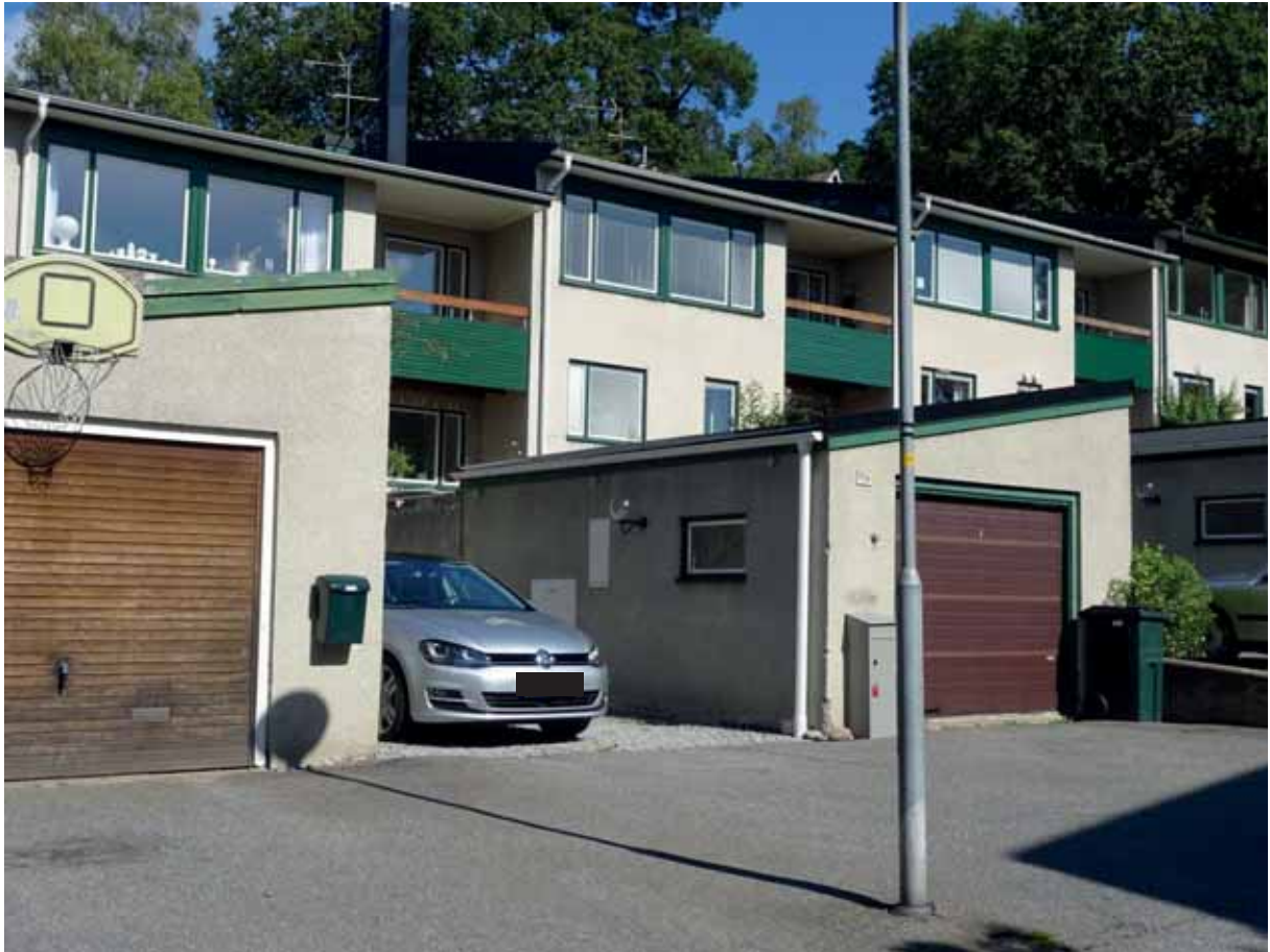
Igelboda 37:19-23 sett från Valhallavägen.
