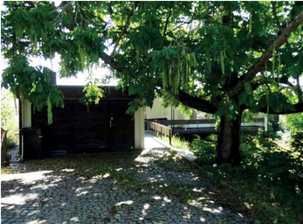
Igelboda 22:11, garaget vid entrén från gatan.
