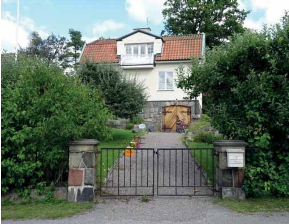
Igelboda 35:2 sett från Valhallavägen.
