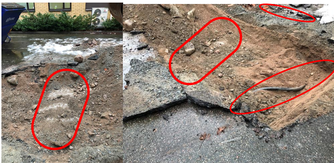
Figur 9. Schaktgrop 1, t.v. betongkonstruktion/-kylvert och t.h. el- och teleledning samt betongkonstruktion.
