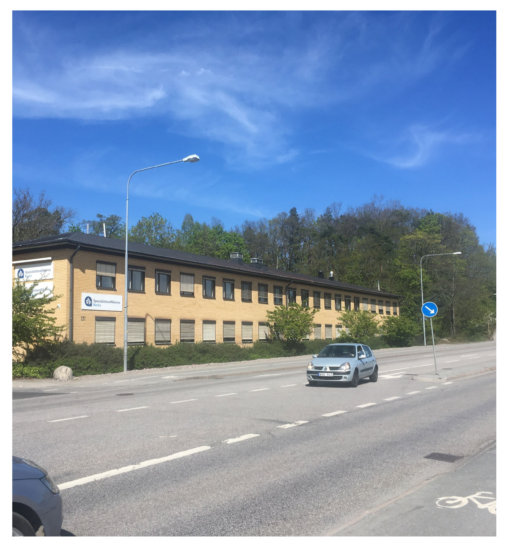
Kontorsbyggnad mot Värmdövägen
