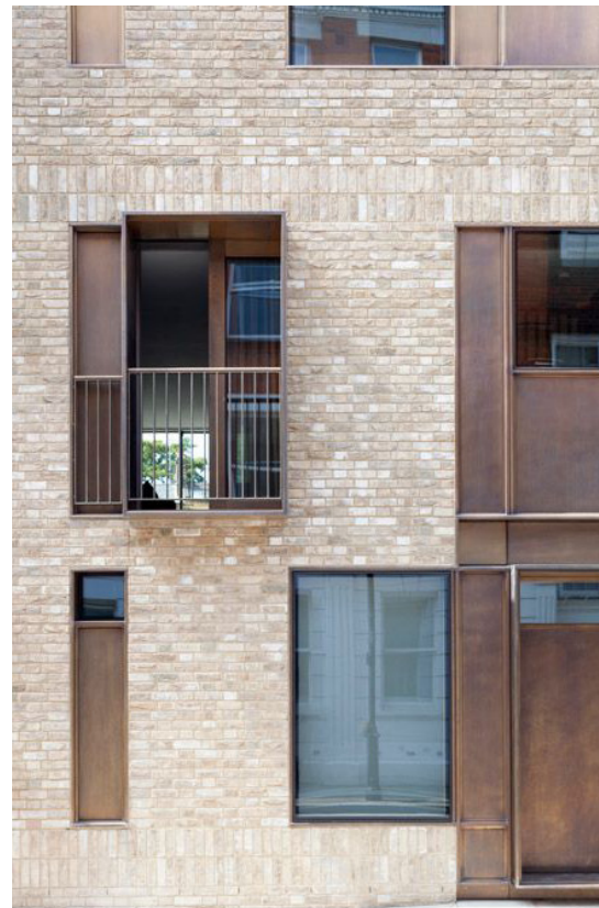
Fönsterkarmar och fyllningar i samma kulör
