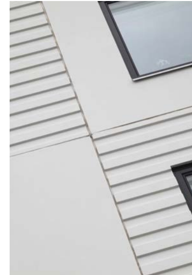
Betongelement med omhändertagna fogar
