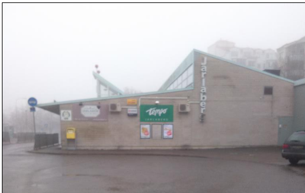
Figur 2. Befintlig fastighet på detaljplanområdet
