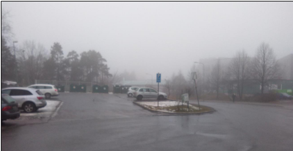
Figur 3. Parkeringsytan avrinner mot rännstensbrunn belägen vid vägkanten vid Jarlabergsvägen.
