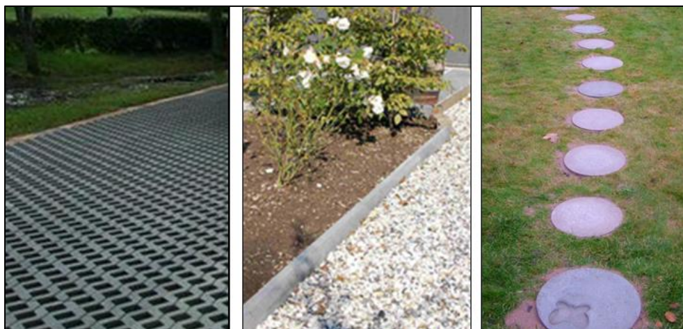
Figur 7. Yta med hålsten av betong, makadambelagd gång, samt gångstig med gräs och ett fåtal gångplattor
