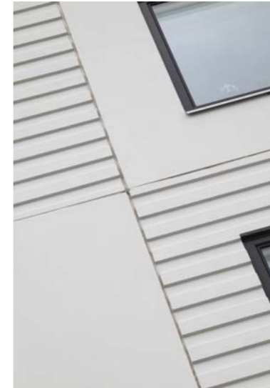
Betongelement med omhändertagna fogar
