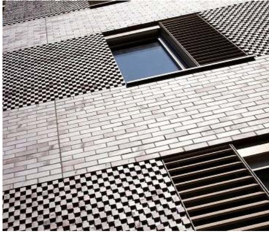
Tegelfasad med mönsterverkan
