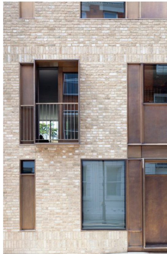
Fönsterkarmar och fyllningar i samma kulör
