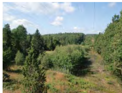
Befintlig kraftledning i västra Kil
