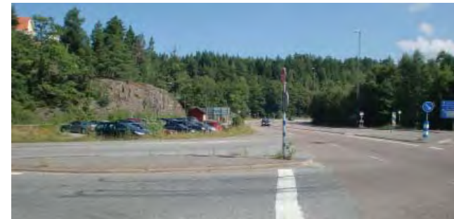
Korsningen Värmdövägen-Gamla Skärgårdsvägen byggs om till cirkulationsplats
