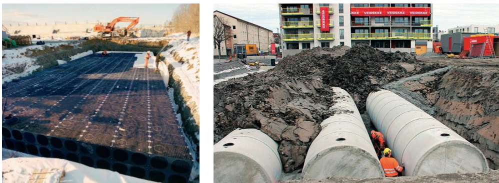
Figur 14. Exempel på underjordiska avsättningsmagasin. Tv: kassettmagasin från Wavin (2013), th: rörmagasin i betong från Meag VA-system (2017).
