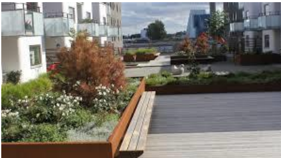
Figur 12 Växtbädd på bjälklag som fördröjer och renar dagvattnet inom kvarteret. Limhamn, Tengbom
