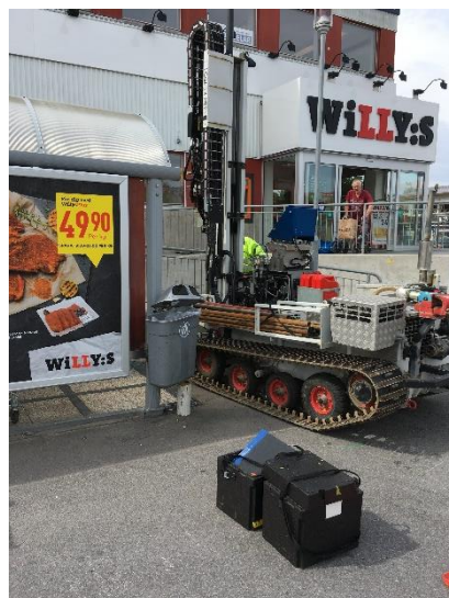
Bild 4. Skruvborrning i BH13 vid Willys entré. Borrstopp vid 3,6 m.u.my.
