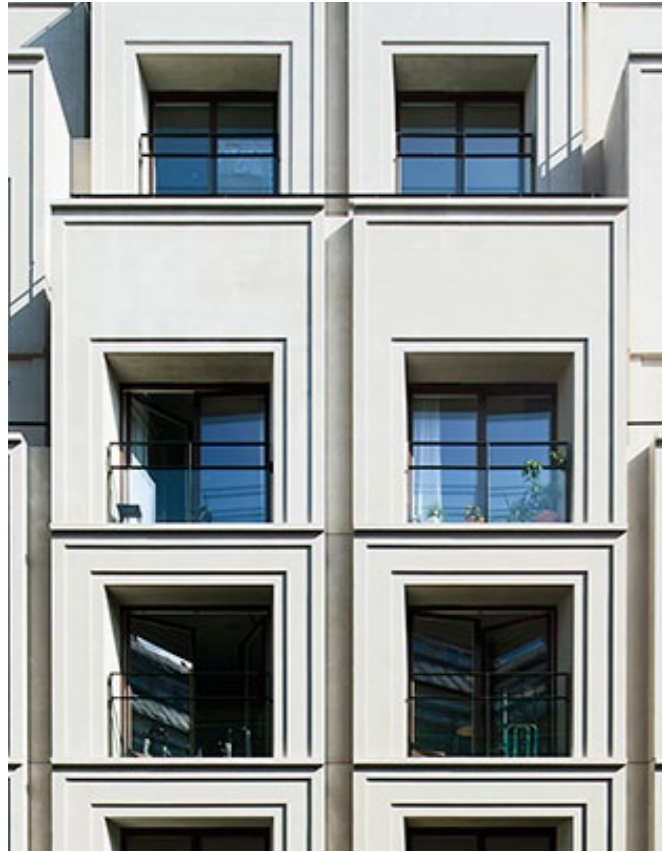
Sandblästrade och infärgade betongelement [Wera arkitekter]
