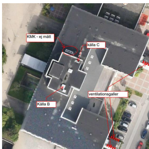
Figur 4. Vy över det västra ormingehuset med uppmätta bullerkällor.
