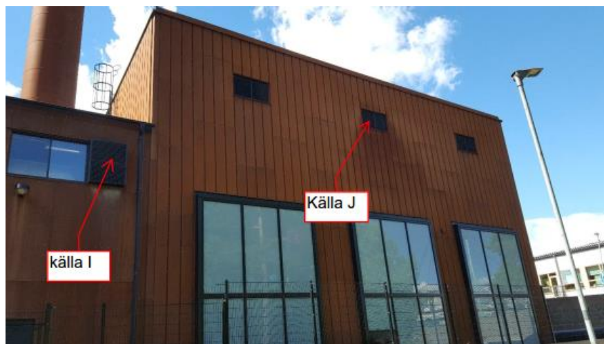
Figur 7. Galler med bakomliggande fläktar i fasad hos panncentralen.
