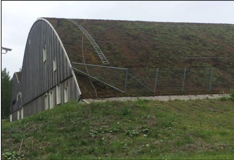
Figur 4. Grönt sedumtak på SEB USIF arena, Uppsala. Foto: Erika Hagström, Structor Uppsala AB (2016).
