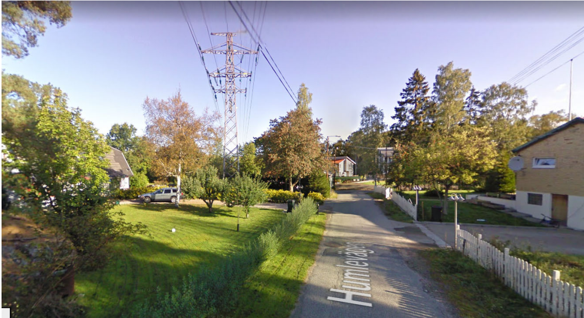
Kraftledningen som idag går genom befintligt bostadsområde.
