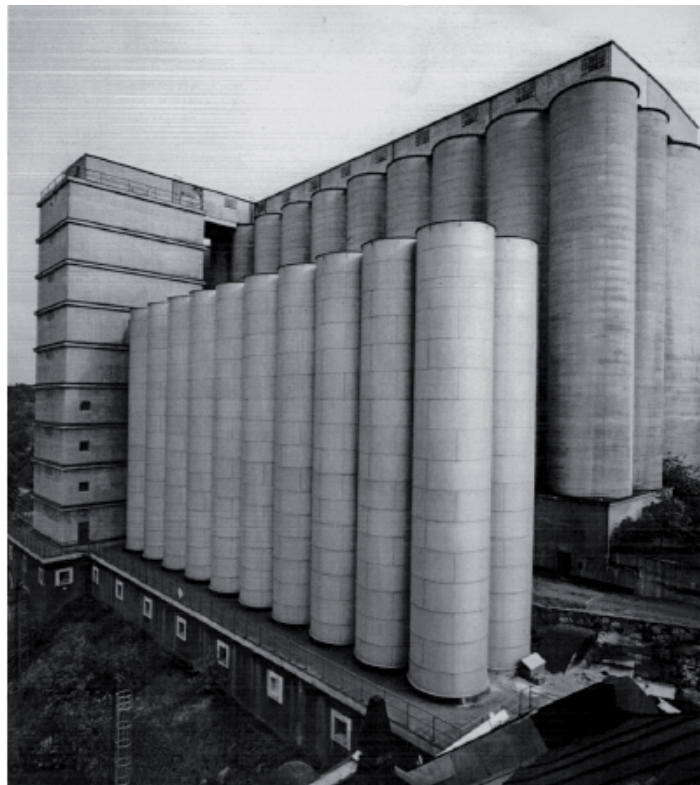
Sockelväningen med fönsteröppningar samt räcke ska bevaras.
