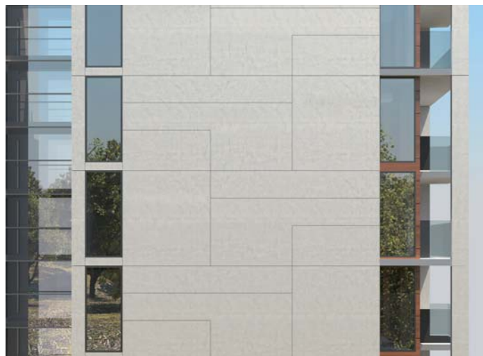
Fasader på hus 19 av betong med reliefmönster.
