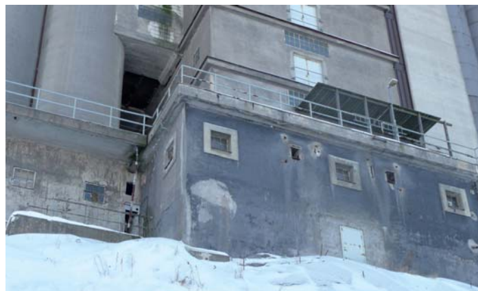
Befintligt metallräcke på sockelns krön.
