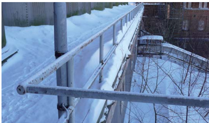
Befintligt metallräcke, detalj.
