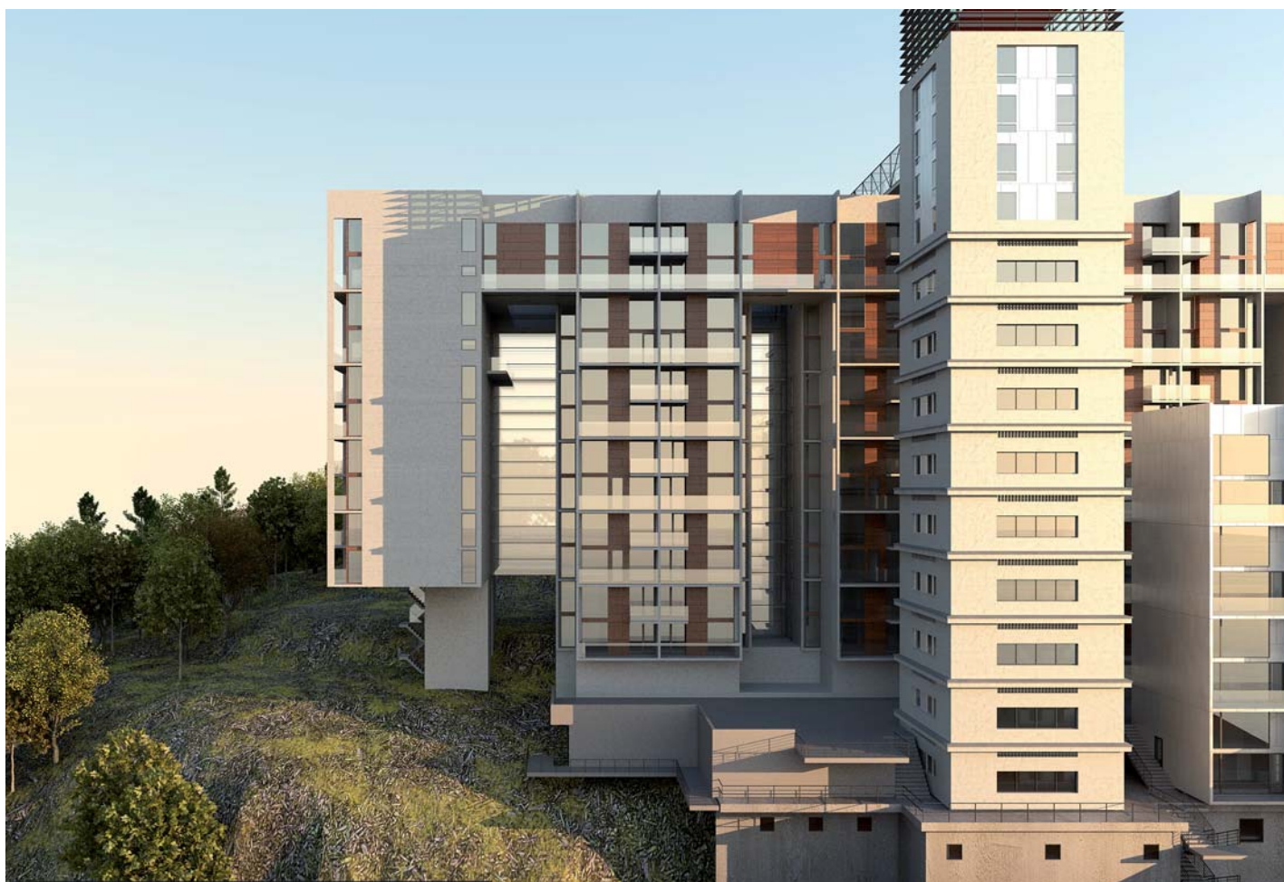
Östra delen av hus 19 sett från norr.
