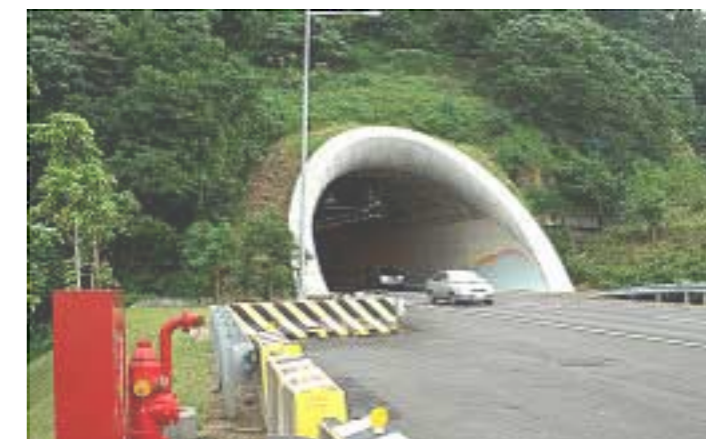
ÅTERSAPAD NATURMARKSKARAKTÄR PÅ BETONG-TUNNEL. HSUEHSHAN, TAIWAN
