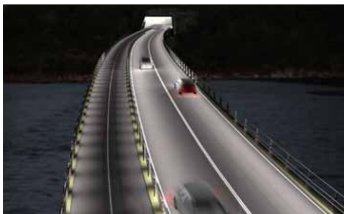
LÅG VÄGBELYSNING LÄNGS VÄGBANOR
