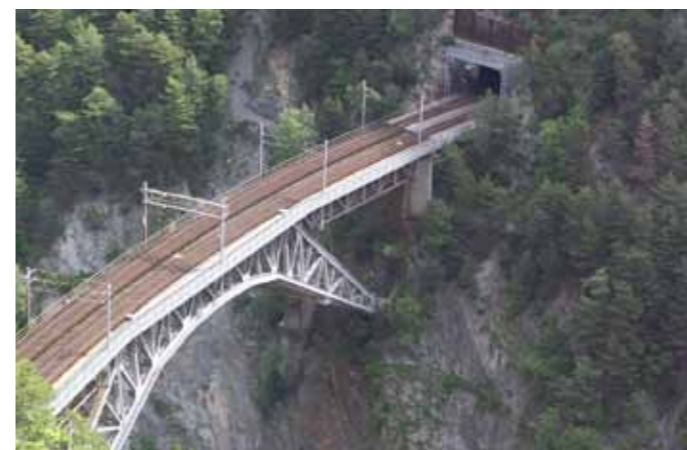
BRO TYDLIGT SPÄND MELLAN BERGSSIDOR ZERMATT, SCHWEIZ
