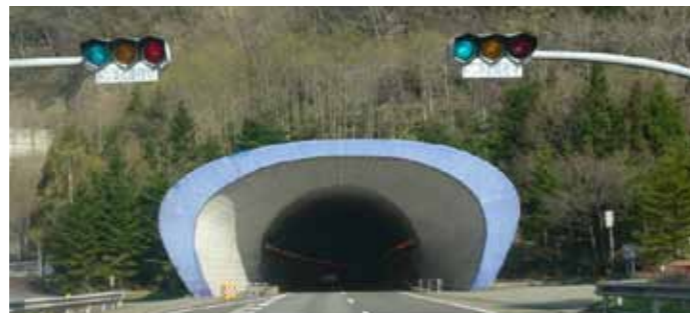
REFERENS ÅTERFYLLNAD PÅ BETONGTUNNEL KAN-ETSU, JAPAN
