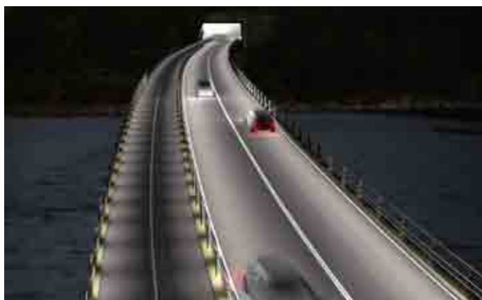
LÅG VÄGBELYSNING LÄNGS VÄGBANOR
