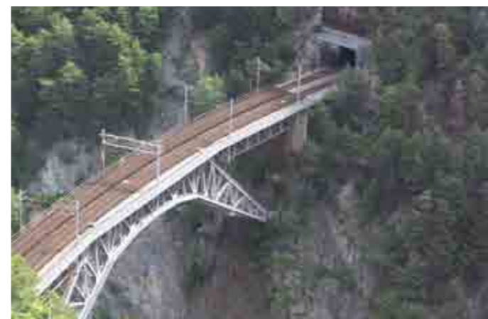
BRO TYDLIGT SPÄND MELLAN BERGSSIDOR ZERMATT, SCHWEIZ
