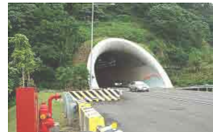
ÅTERSAPAD NATURMARKSKARAKTÄR PÅ BETONG-TUNNEL. HSUEHSHAN, TAIWAN
