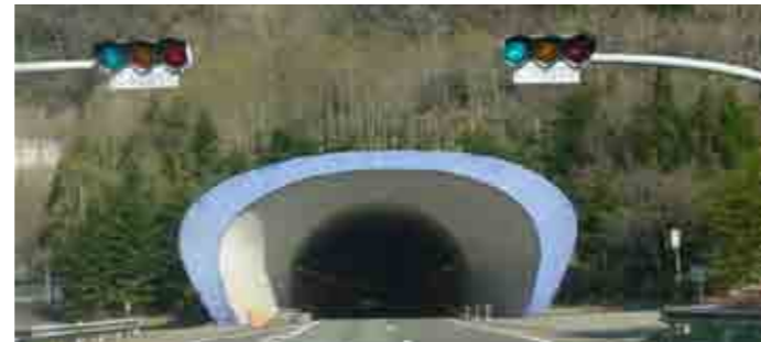
REFERENS ÅTERFYLLNAD PÅ BETONGTUNNEL KAN-ETSU, JAPAN
