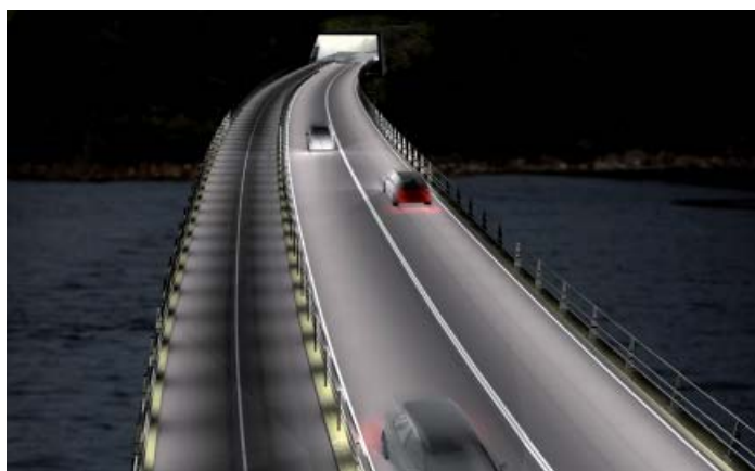
LÅG VÄGBELYSNING LÄNGS VÄGBANOR
