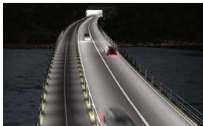
LÅG VÄGBELYSNING LÄNGS VÄGBANOR
