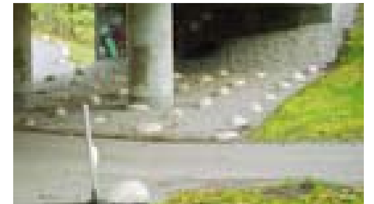
EXEMPEL MED STENAR I RADER UNDER EN VÄG-PORT. EN STÅLKANTHÖR GÖR ATT GRÄNSEN MEL-LAN GRÄS OCH GRUS BEHÅLLS SKARP. (GULLMARS-PLAN)
