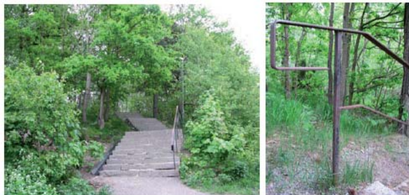
BEFINTLIG TRAPPA OCH RÄCKE
