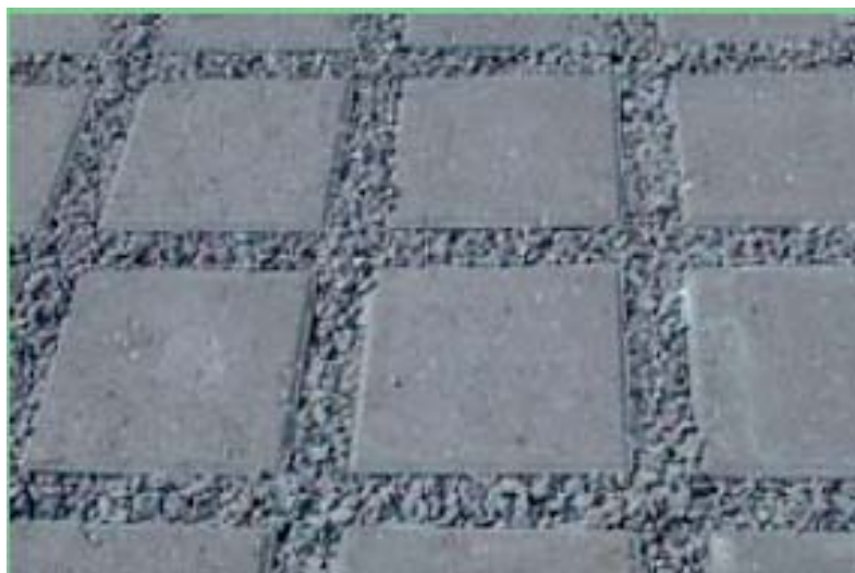
EXEMPEL PÅ MARKPLATTOR MED GENOMSLÄPPLIGA, GLESA FOGAR.
