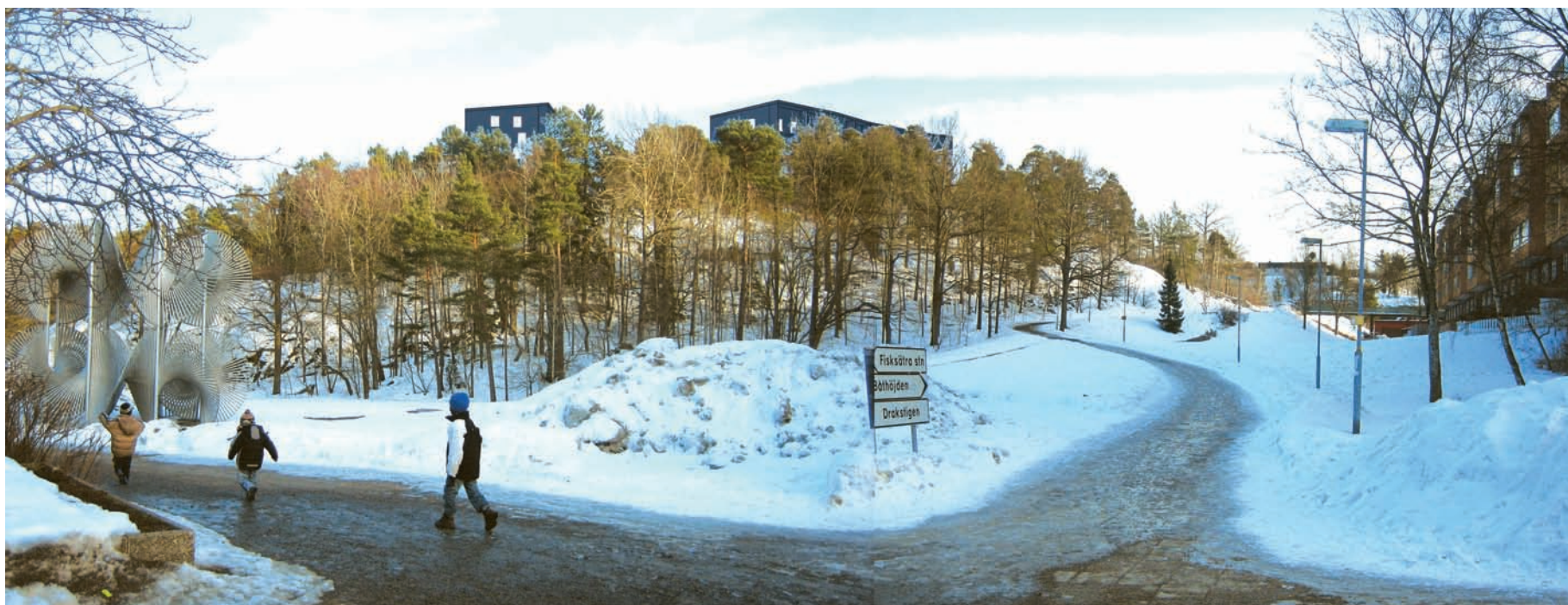
LÄNNBOHÖJDENS BOSTADSHUS SETT FRÅN FIKSÄTRA ALLÉVÄG
