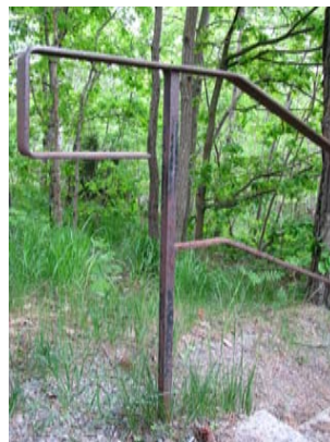
BEFINTLIG TRAPPA OCH RÄCKE
