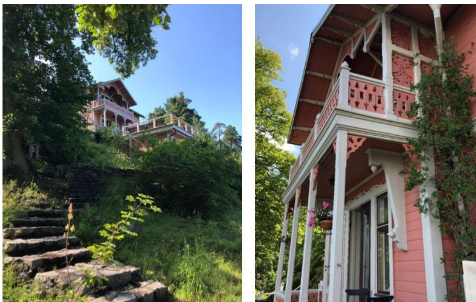
Figur 3: Huvudbyggnaden på fastigheten Björknäs 10:4. Bilderna visar huvudbyggnadens exteriör med lövsågade detaljer, samt den starka kuperingen på fastigheterna och tomtens grönskande karaktär.
