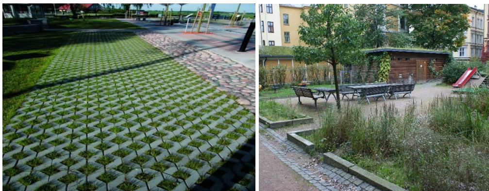
Figur 10: Exempel på hur en genomsläpplig beläggning kan vara utformad (vänster) samt en innergård med växtbäddar som inte är hårdgjord (höger).
