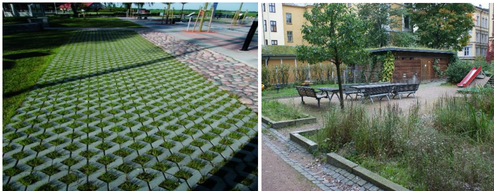
Figur 8: Exempel på hur en genomsläpplig beläggning kan vara utformad (vänster) samt en innergård med växtbäddar som inte är hårdgjord (höger).
