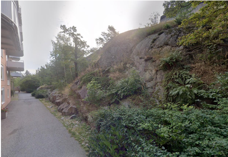
Figur 15: Riskområde för blockutfall. Bild tagen från Google Maps.
