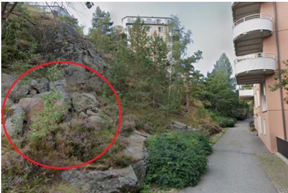
Figur 16: Riskområde för blockutfall. Bild tagen från Google Maps. Lösa block (röd cirkel) som eventuellt kan ha lossnats och ansamlats vid släntens fot.
