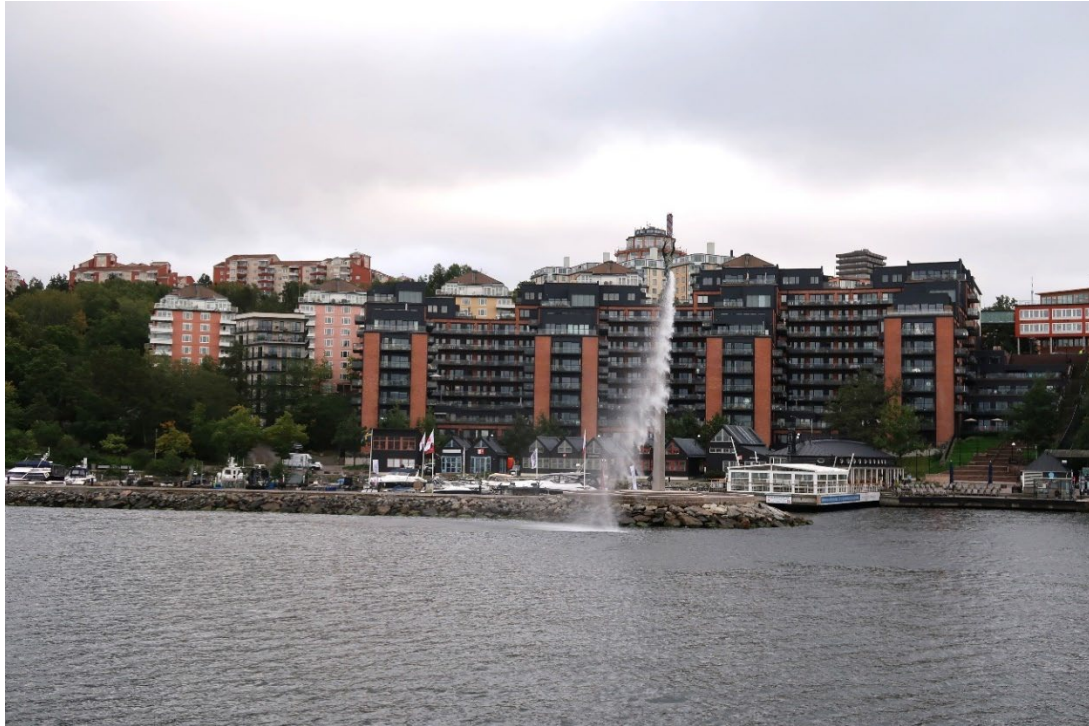
Vy mot detaljplaneområdet från farleden norrifrån, rakt från pendelbåtsbryggan vid Nacka strand.
