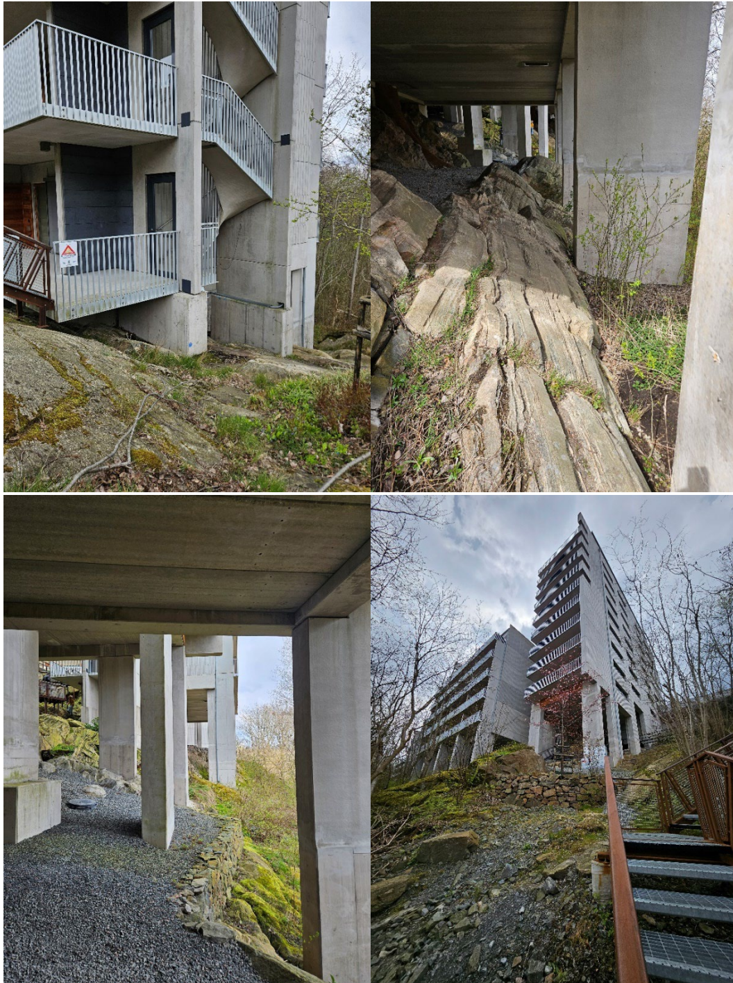
Exempel på en grundläggning med pelare som är varsamt inpassade i en brant naturslutning. Brf Viva i Guldheden i Göteborg.
