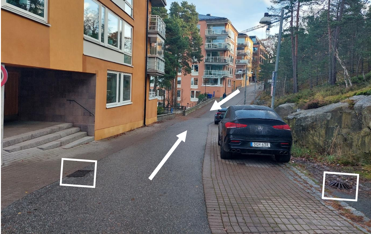
Figur 2-9. Fabrikörsvägen fotograferat i östlig riktning mot lågpunkten. I lågpunkten finns även en brunn.
