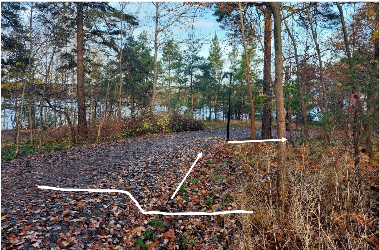
Figur 2-8. Grusvägens förhöjning ses i bild förstärkt med utritade markör i vitt och avledningsriktning.
