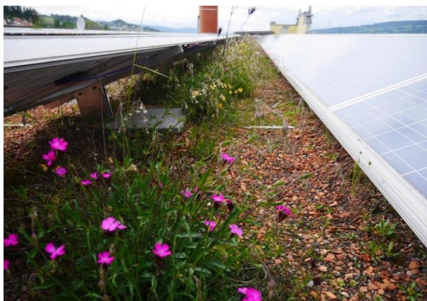
Grönt tak i kombination med solceller.
