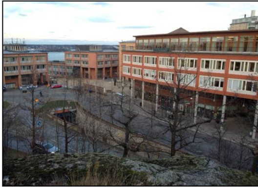
Utblick över Augustendalsvägens hållplatser
