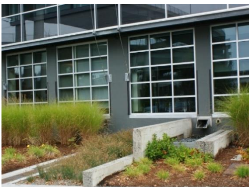
Växtbäddar på kvartersmark tar emot dagvatten från stuprörutkastare.
