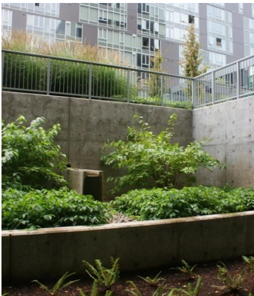
Avvattning av terrasserade innergårdar med hjälp av planteringar, rännor och överfall.
