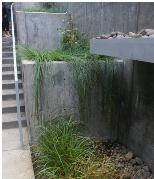
Avvattning av terrasserade innergårdar med hjälp av planteringar, rännor och överfall.
