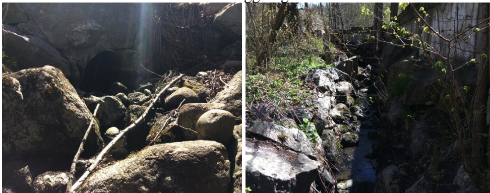
Figur 4 & 5. Till vänster i bild syns trumman mellan delsträcka 1 & 2. Till höger i bild syns delsträcka 2 i sin helhet.
