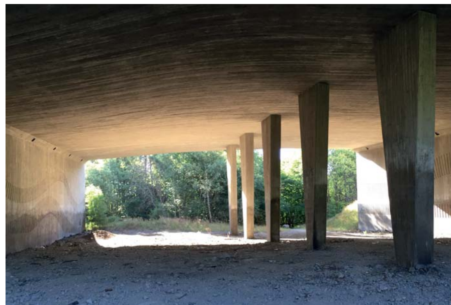
Området under Väg 222 i Augusti 2016.
