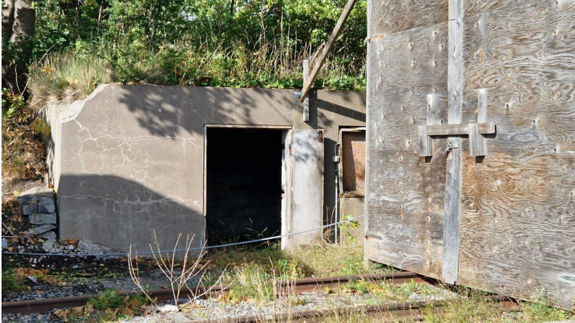
Figur 17. Mot Torsvägen finns en betongkällare som troligen är den oljekällare som nämns i ett arrendeavtal från 1969. Källaren kan komma att rivas som en följd av förslaget.
