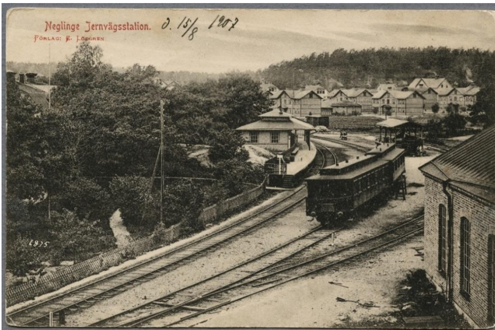
Figur 6. Vykort från 1907 som visar Neglinge station med lokstallet i tegel till höger. Järnvägsmuseet Gävle. JvmKCAC05307.
