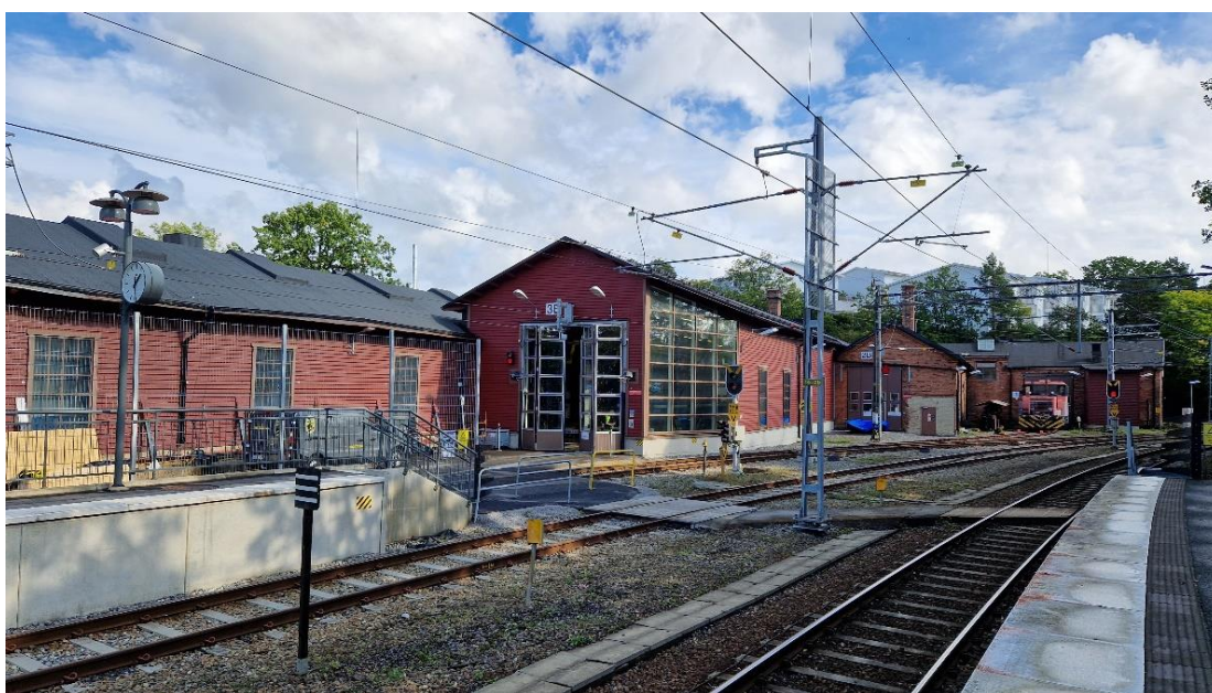
Figur 22. En av de äldre verkstadsbyggnaderna i tegel har förlängts med en ny hall. Nybyggnaden har anpassats till miljön vad gäller takvinkel, fasadmateriel och fönstersättning.
