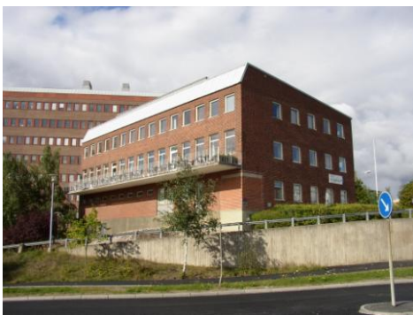
Matsalsbyggnaden från 1961. Foto 2009
