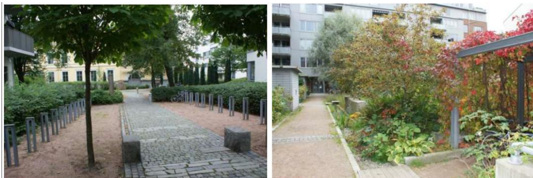
Figur 18. Permeabel beläggning på innergårdsområde.
