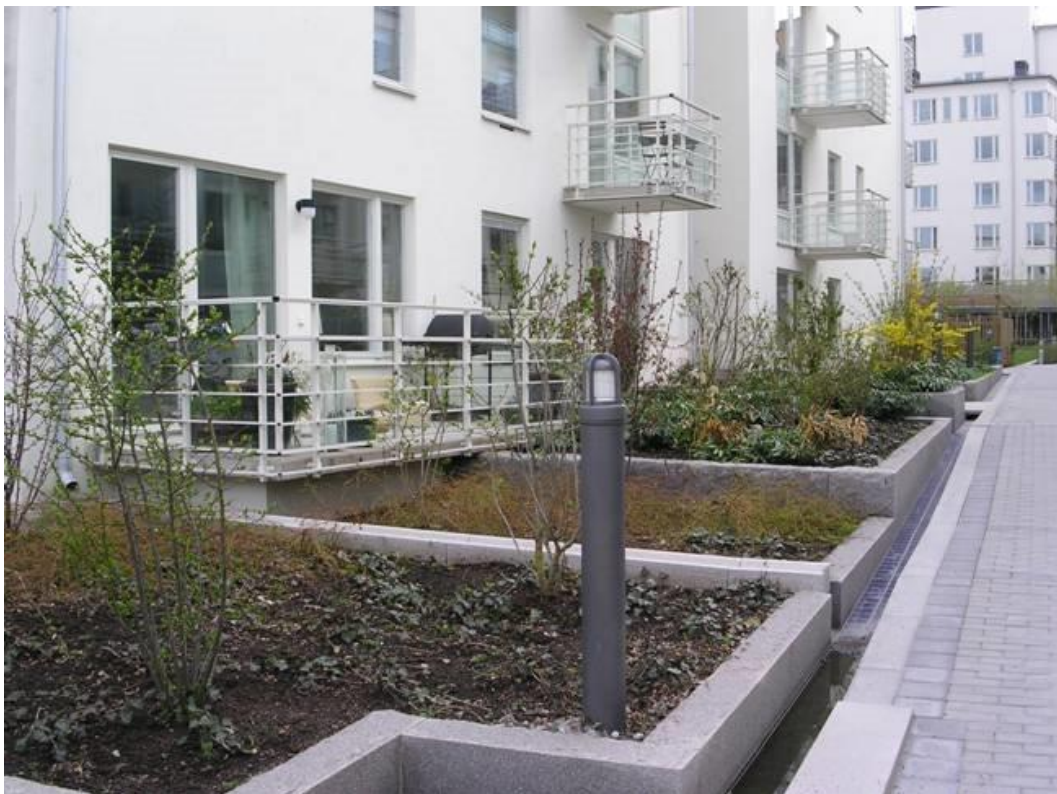
Figur 16. Stuprörsutkastare (till vänster) på ett flerfamiljshus med avledning till växtbädd.
