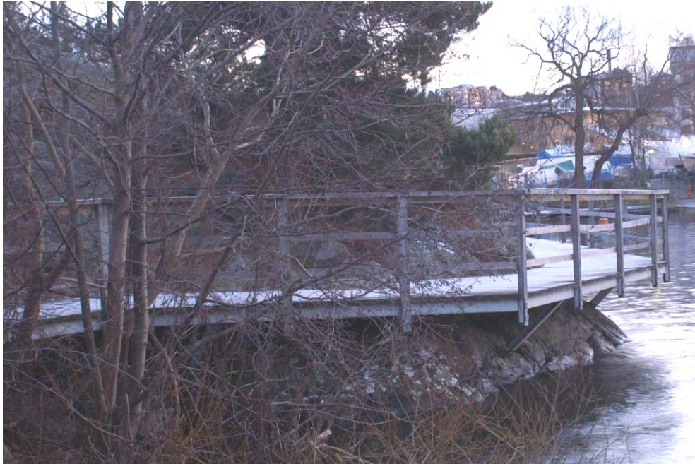
Exempel på gångbrygga
