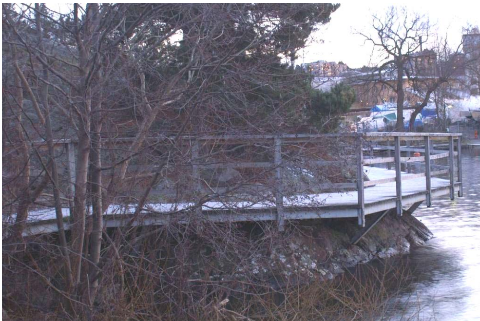
Exempel på gångbrygga
