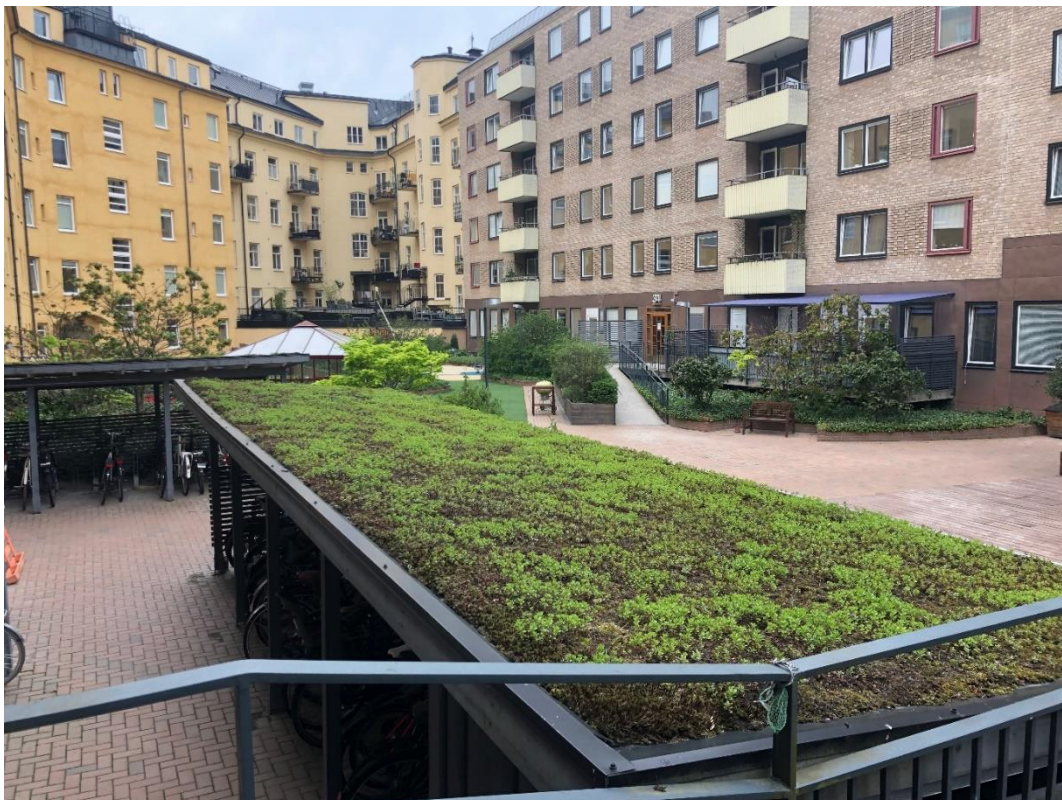
Figur 14. Ett exempel på ett grönt tak över en cykelparkering på Södermalm i Stockholm (Foto Bjerking).
