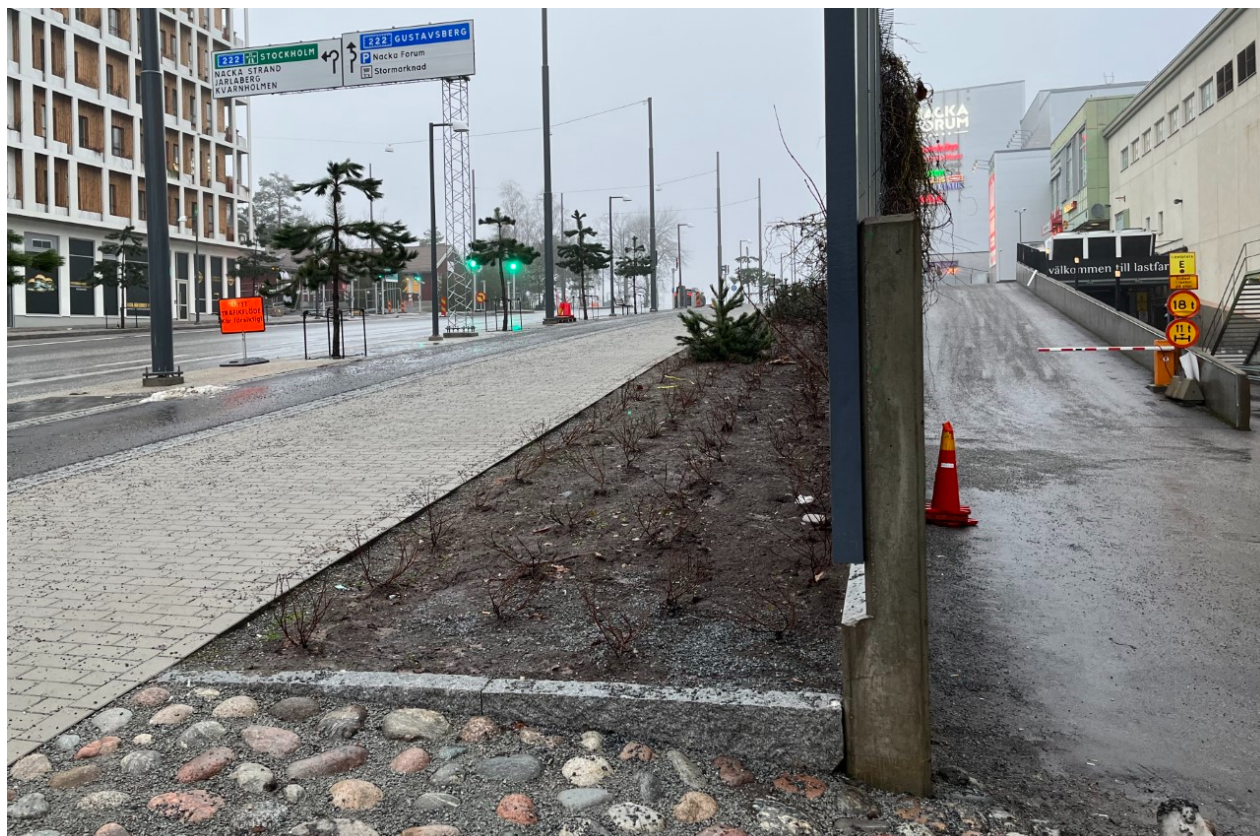
Foto 2: Vikdalsvägen till vänster i fotot följt av trottoar med trädplantering, asfalterad cykelväg, stensatt gångväg, plantering, stödmur, lastfaret samt rampen upp till den övre lastkajen som skymtar till höger i fotot.
