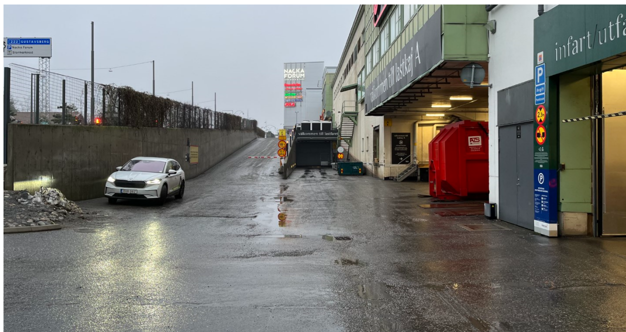
Foto 1: Förgårdsmark mellan Vikdalsvägen och galleriabyggnaden med ramp till övre lastkaj samt in/utfart ned till gallerians garage. Rampen vilar på stödmuren mot Vikdalsvägen och på ytterligare en stödmur.
