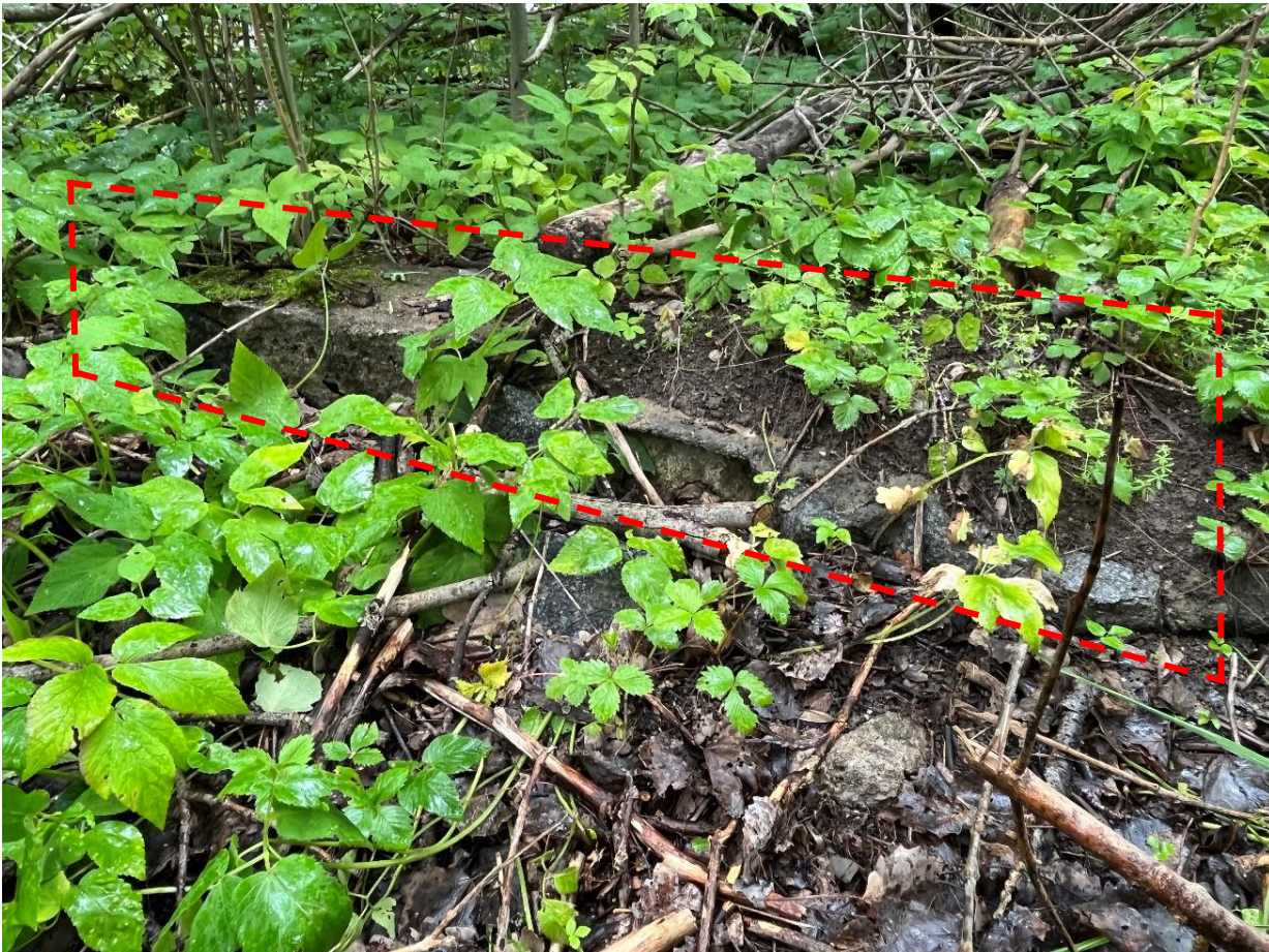
Figur 3: Bild som visar den tidigare husgrunden i längsgående riktning. Foto från platsbesök 2023-08-09.
