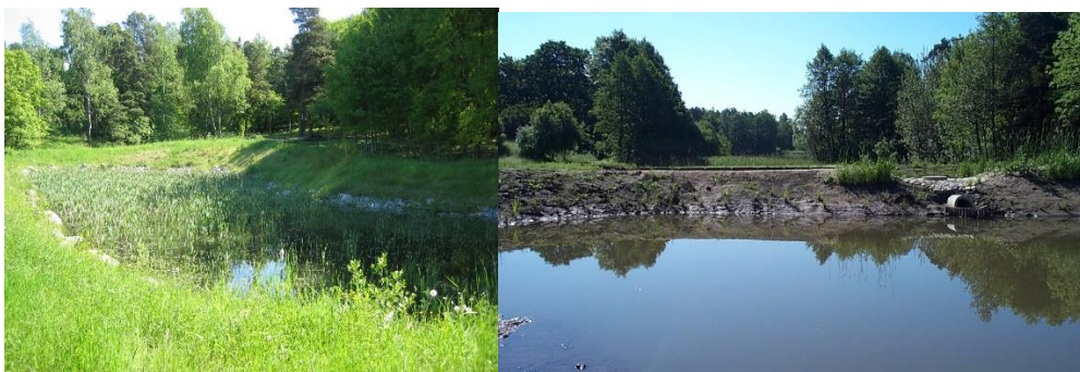
Figur 27 - Exempel på dagvattendammar (Foto: Sweco).
