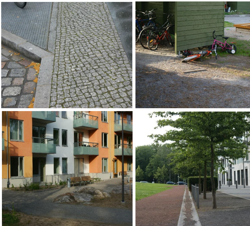
Figur 16 - Exempel på permeabla beläggningar (Bild: Sweco).
