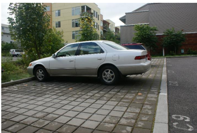
Figur 28 - Exempel på parkering med permeabla beläggningar.
