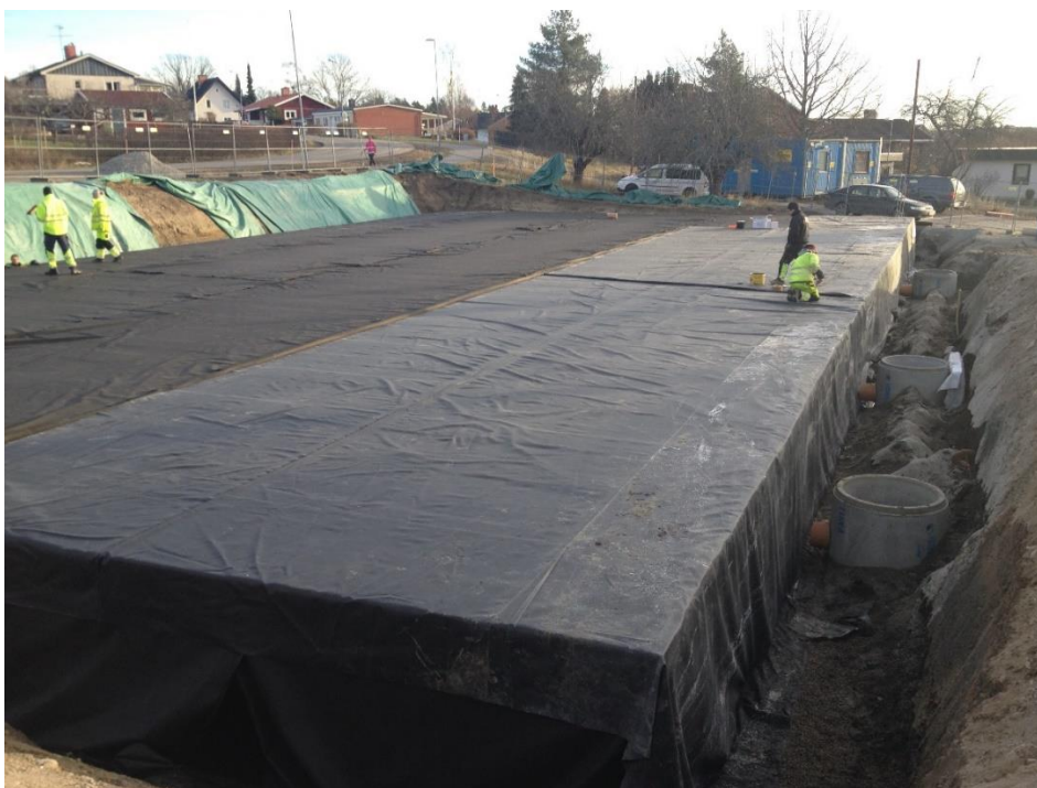
Figur 19 Anläggning av fördröjningsmagasin med plastkassetter
