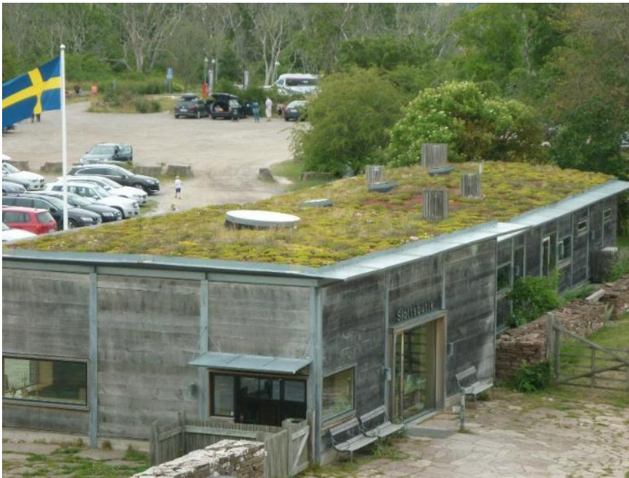
Figur 11. Exempel på tak som utformats med sedum. Foto: WRS
